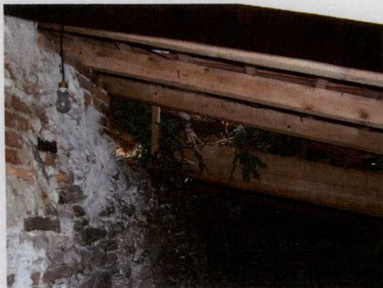
Allestimento ponteggio per la rimozione dei rami ed il ripristino della copertura
