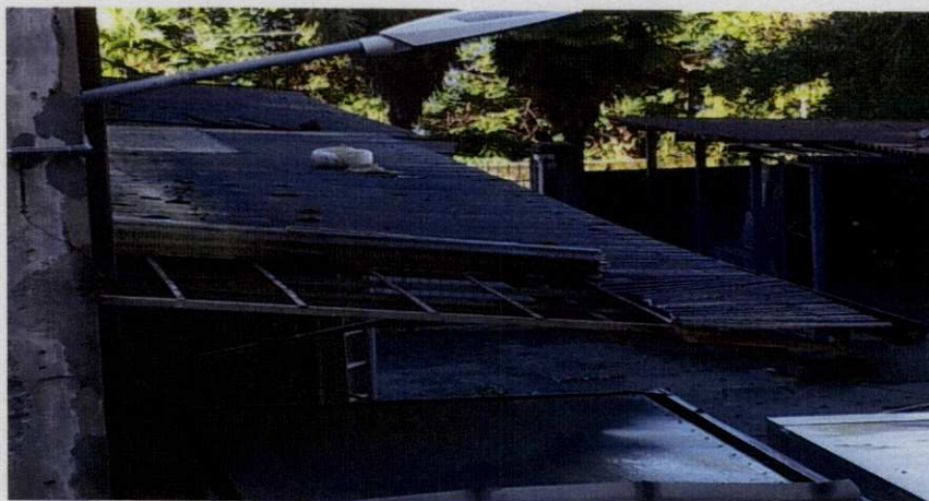
Danneggiamenti vari agli infissi, vetri rotti, battenti divelti, infiltrazioni, parete in cartongesso
