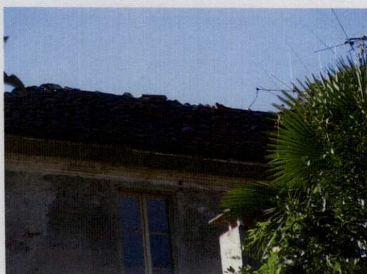
Scoperchiature del tetto con caduta di coppi tegole e del camino
