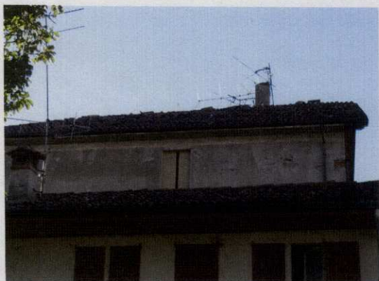
Scoperchiature del tetto con caduta di coppi tegole e del camino
