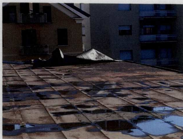
Strappo del manto impermealizzante della copertura del reparto di Pediatria
