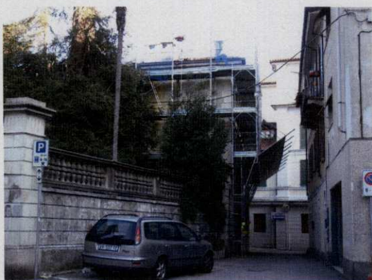
Allestimento ponteggio per la rimozione dei rami ed il ripristino della copertura
