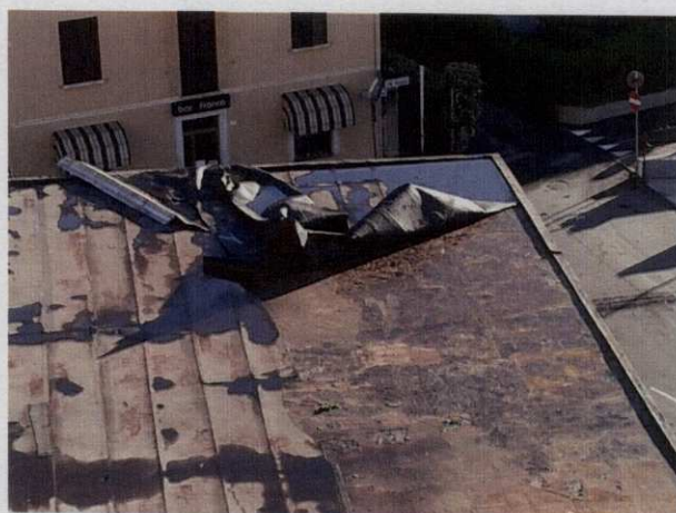
Strappo del manto impermealizzante della copertura del reparto di Pediatria
